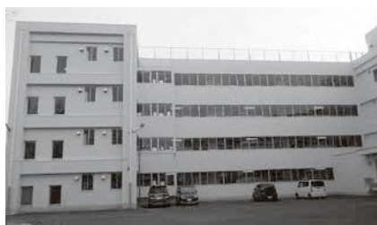
屋上防水及び外壁改修工事が行われた 約築45年の第二中学校
