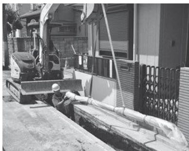
古い水道管の耐震化を図るため地震に強い管に更新
