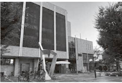
市民体育館前の北プラザ
