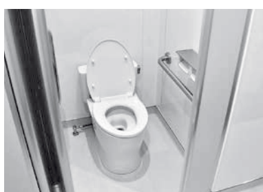
改修後の塚越小学校トイレ
