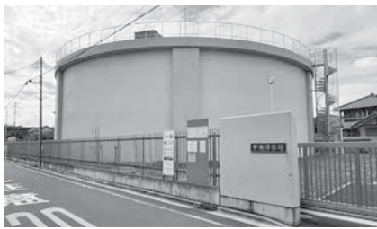
次期水道ビジョンで建替え工事計画が実施される予定の中央浄水場
