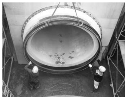
マンホールと下水道管の接合部分を耐震化する工事風景
