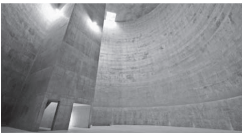
貯留容量5,300立方メートルを有する北町1丁目の雨水調整池
