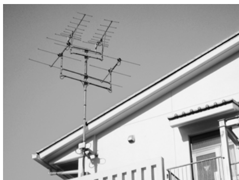
電波障害改善の為に設置されている共聴アンテナ（北小）
