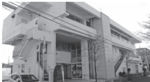
公共施設LED化の推進を（写真は南公民館）
