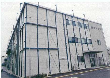
(北町2丁目地内の仮設庁舎)
